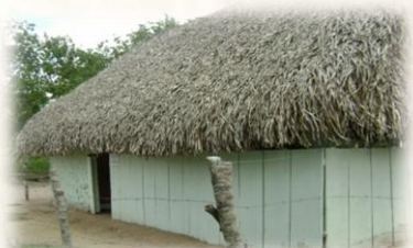
Foto 86. Vista lateral escuela Las Providencia
