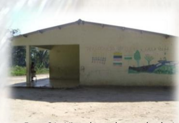
Foto 81. Vista lateral escuela de Las Vegas
